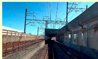
新習志野方面へ向う線路とは、立体交差で分れていく。(西船橋～市川塩浜)
