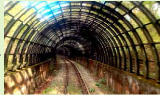
豪雪地帯を走るので、線内の至る所に雪崩覆いが設置されている。(上境～上桑名川)
