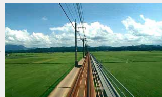
防音壁がない高架線を走るので、眼下に広がる田園地帯の眺めもいい！(犀潟～くびき)
