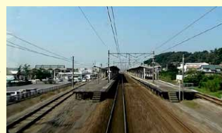
北陸新幹線の駅ができる加賀温泉だが、まだ工事にかかる様子が窺えない。
