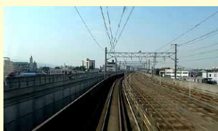
金沢を発車。駅構内の外れまで、工事中的の北陸新幹線の様子を眺めることができる。
