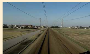
現在、この真上あたりには北陸新幹線の高架橋が横切っている。 (明峰～寺井)
