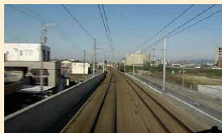
福井を出ると、北陸新幹線の工事が徐々に始められている区間がある。 (福井～森田)
