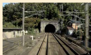
敦賀を発車すると、ほどなく13870mの北陸トンネルに入る。
