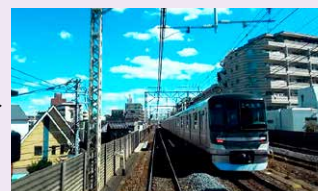
複々線区間では緩行線のメトロ車(13000系)を走行中に追い抜いていく。(梅島～五反野)
